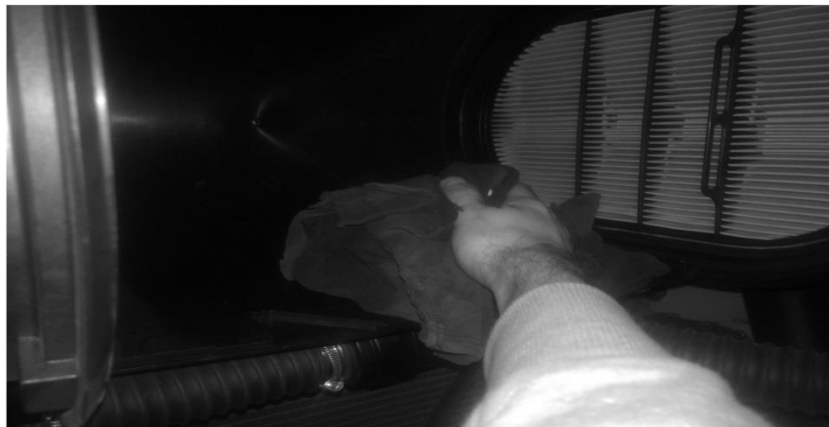
Рисунок 161 Очистка корпуса фильтра
